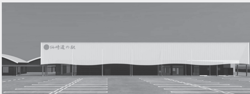
仙崎地区グランドデザイン基本計画に基づき、仙崎のまちなみ整備と並行して、現在の青海島観光基地に整備が予定されている「道の駅」機能を有する農林水産物などの直売所およびレストランの建設工事に着手します（仙崎地区グランドデザイン整備事業）
