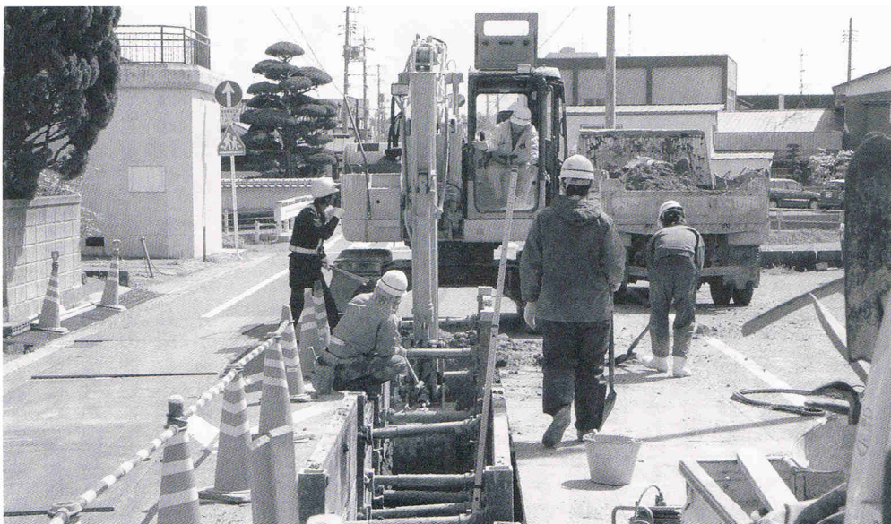
農業集落排水事業の工事（油谷地区）
