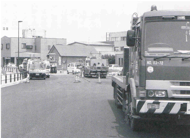
工事中の瀬戸下郷線
