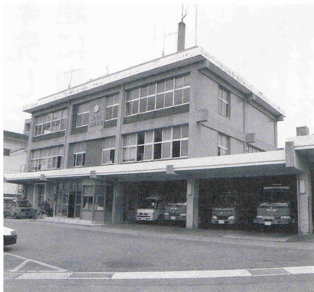
耐震化への対応が望まれる消防本部
