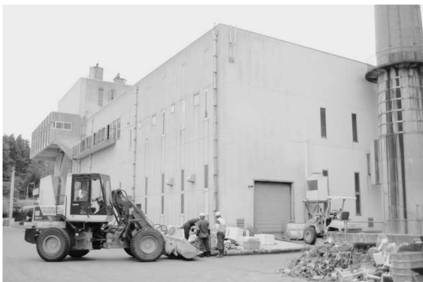
老朽化が進むゴミ焼却場
