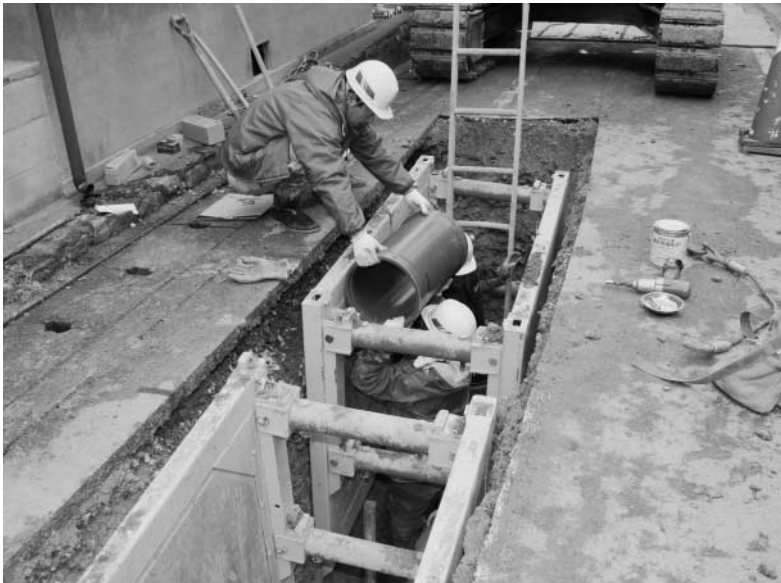
下水道整備の工事（油谷地区）
