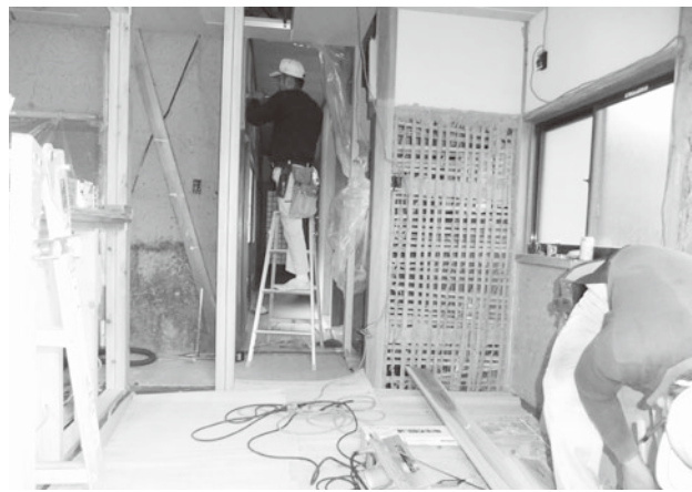
市内業者によるリフォーム現場
