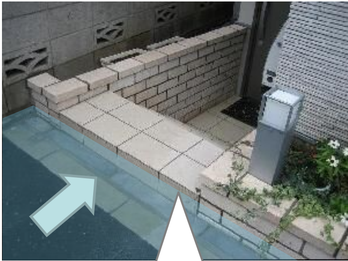
防水性の塀により浸水を防ぐ。
