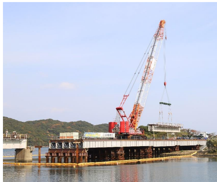
(12/3 栗野川橋りょう復旧工事の様子)
