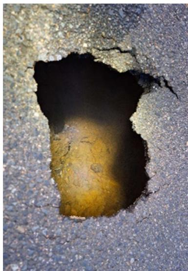
老朽化した下水道管の破損により陥没した道路(左)と陥没部分(右)
