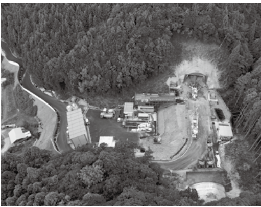
▼工事中の依山第2トンネル
