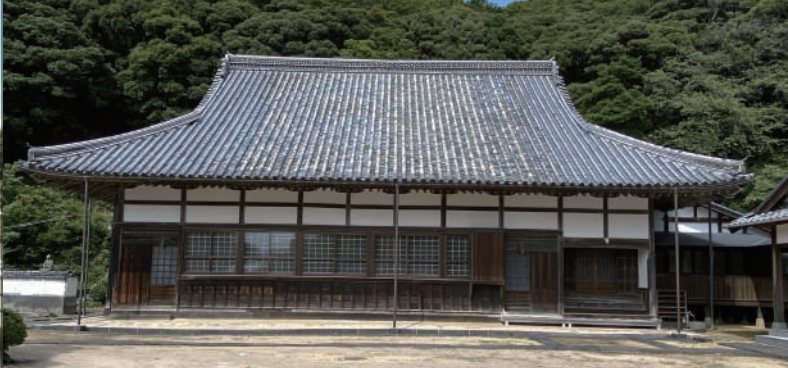
(左)重要文化財(建造物)早川家住宅、(中、右)山口県指定有形文化財(建造物)西園寺山門・本堂
