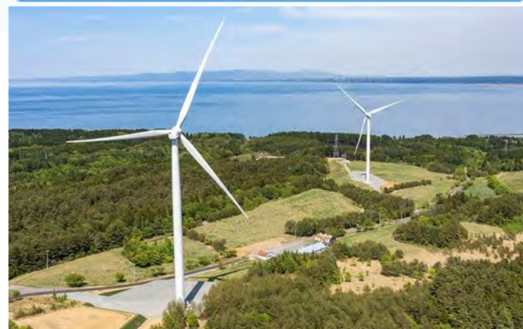
野辺地柴崎風力発電所
