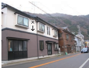
×明るい色調の新建材の外壁
