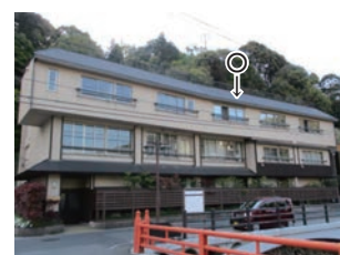
○通り沿いは傾斜屋根とし、背後の陸屋根部分に設備機器を隠す工夫
