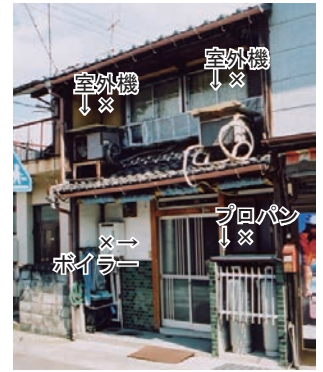
×露出した設備機器
