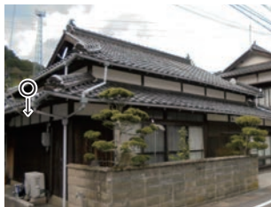
○下見板張り しんかべ と漆喰に木組みの外壁
