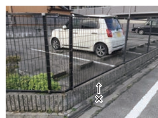
×金網フェンス
