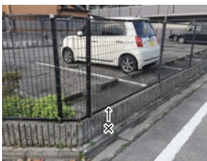
×金網フェンス
