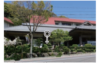
○造園による法面の処理
