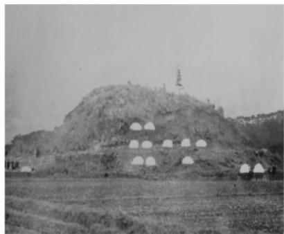
すくもづか 『消滅前の 榑塚横穴墓群』 大正十二年ごろ撮影 （写真出典 長門市の遺跡より）
