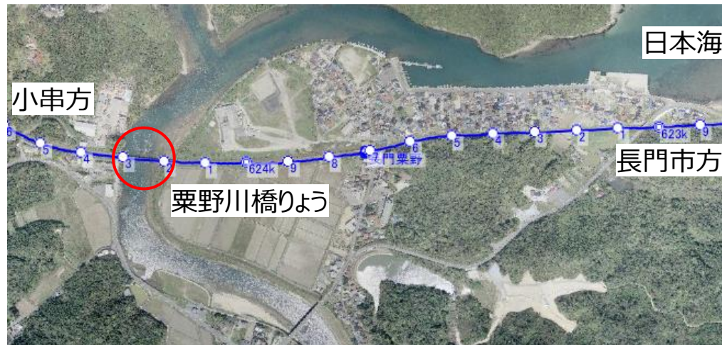
長門栗野・阿川間栗野川橋りょう橋脚傾斜
