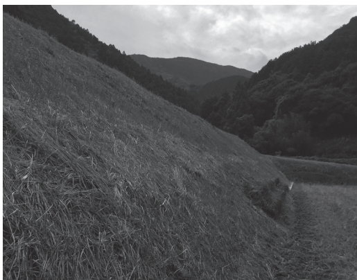
▼圃場整備したところの急な法面
