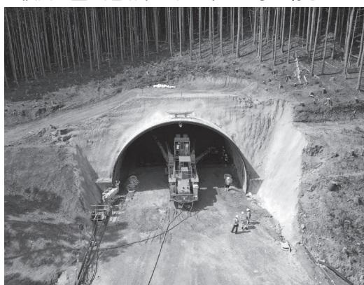
▼俵山・豊田道路第1トンネル工事の様子
