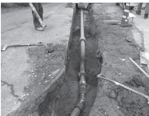
▼老朽化した管路の更新
