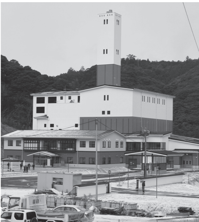
▲新清掃工場「はなもゆ」の外観
