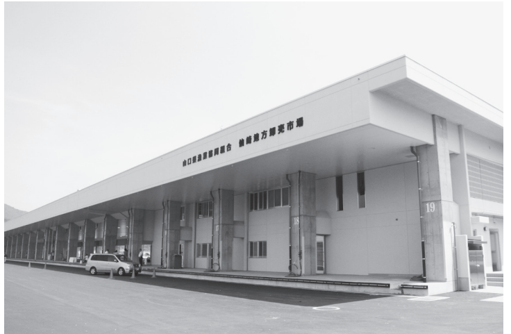
▲平成 24 年 7 月に完成した仙崎新市場
