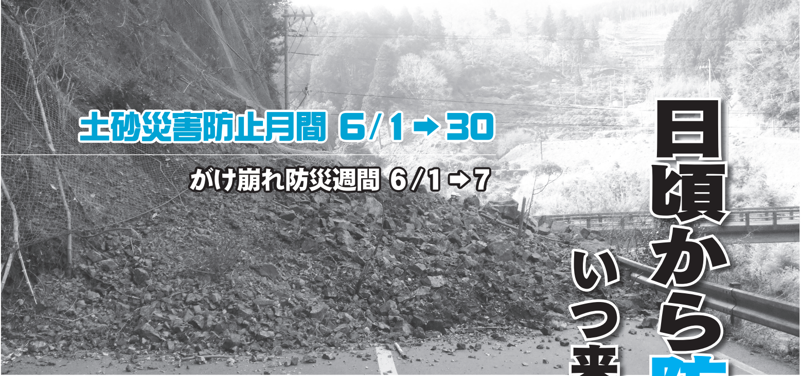
▲平成 24 年 2 月 25 日に突如発生した土砂崩れ（俵山地区）
