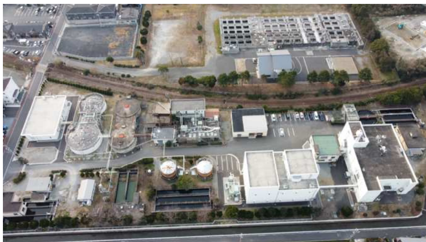
東深川浄化センター
