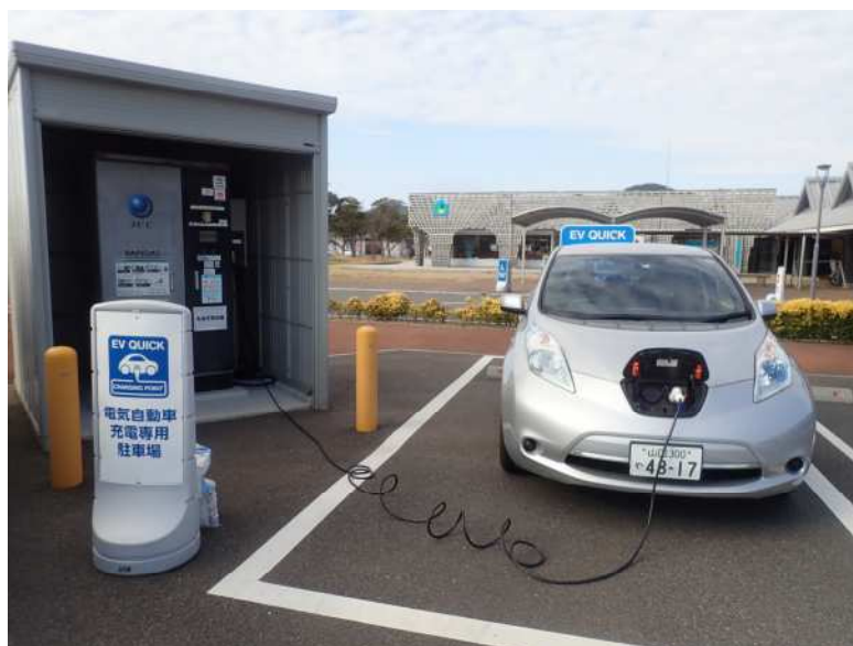
EV専用急速充電器の設置
