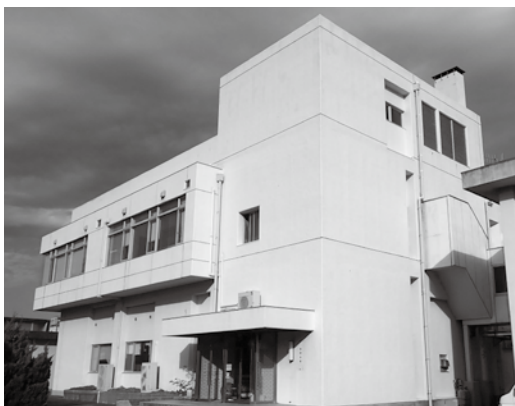
▼東深川浄化センター
