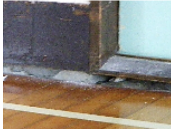
床の沈下
