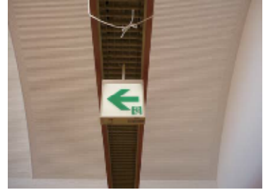
誘導灯の点灯状態の確認
