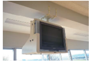
天井取付部の確認
