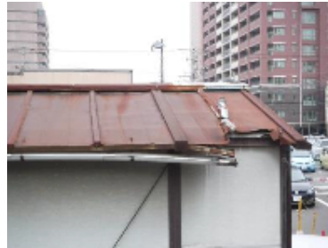
金属屋根の飛散
