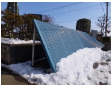
積雪による倒壊
