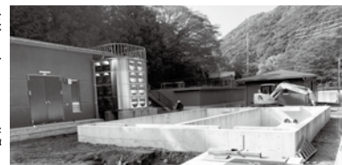
▲更新工事が進む湯本浄水場
