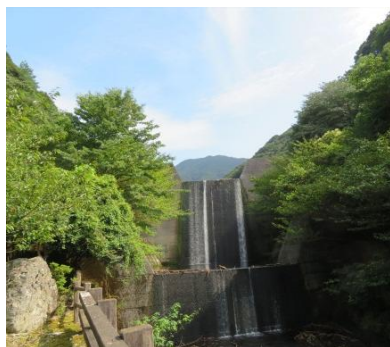
大谷本浴川砂防堰堤
