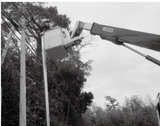
▼光ファイバー布設工事
