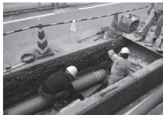
▲水道管布設替工事
