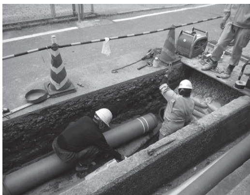
▼水道管布設替工事
