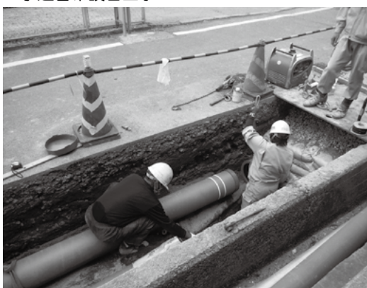
▼水道管布設替工事
