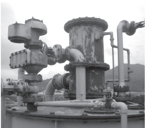
▲老朽化が進む施設
