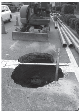
▲管破損による道路陥没
