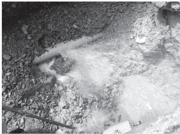
▲老朽化による水道管の漏水
