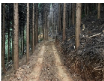
その後の作業道 作設風景
