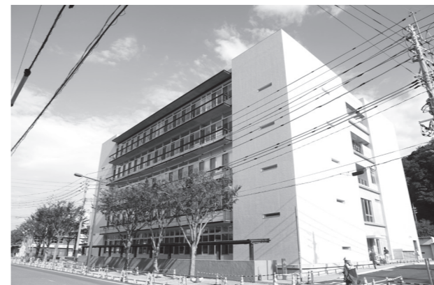
▲木造と鉄筋コンクリート造のハイブリット構造
