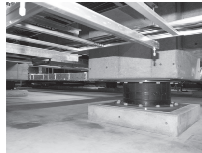
▲免震構造を採用し、最高水準の耐震性能を確保。災害から庁舎を守る
