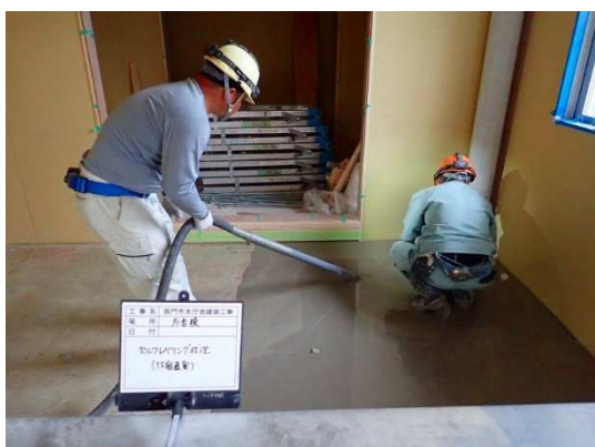
セルフレベル打設状況
