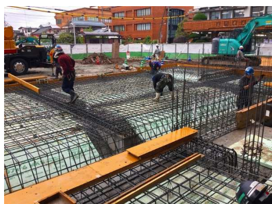
エントランス棟 土間配筋状況
