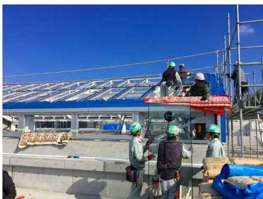
トップライトガラス取付状況
