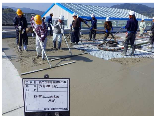
屋上 押さえ CON 打設状況
