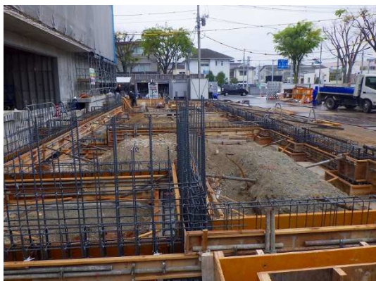
エントランス棟 地中梁配筋状況
