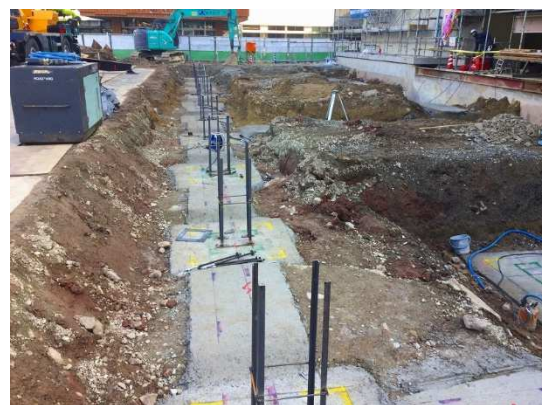
エントランス棟 ベース CON 打設完了
