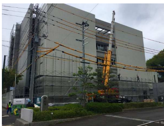
東面外部足場解体状況
