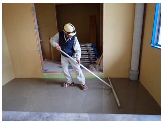
セルフレベル打設状況
