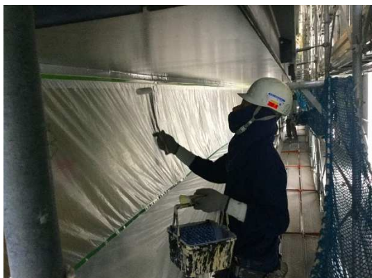
外部軒天クリア塗装状況
