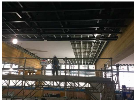
天井ボード張付け状況
