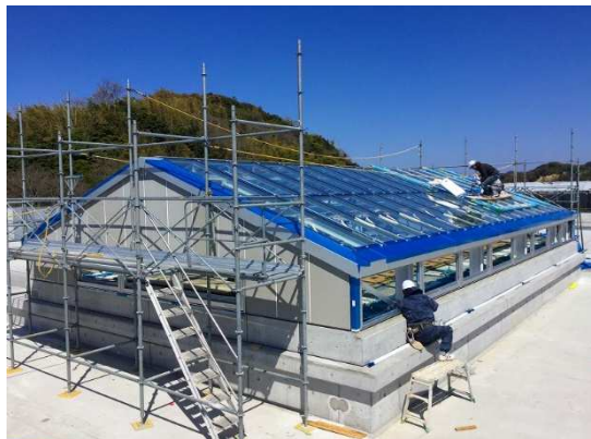
トップライトガラス取付完了
