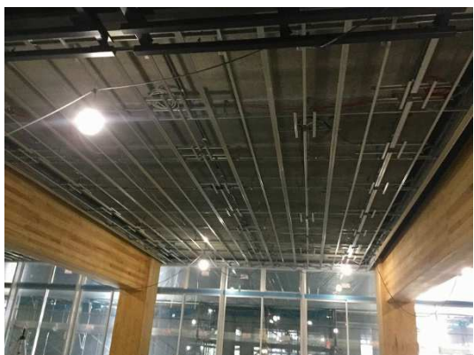
天井下地組状況
