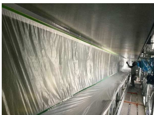
外部軒天クリア塗装状況
