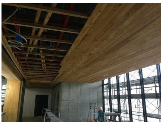
天井板貼り状況
