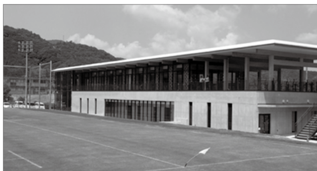
▼ 俵山多目的交流広場クラブハウス
