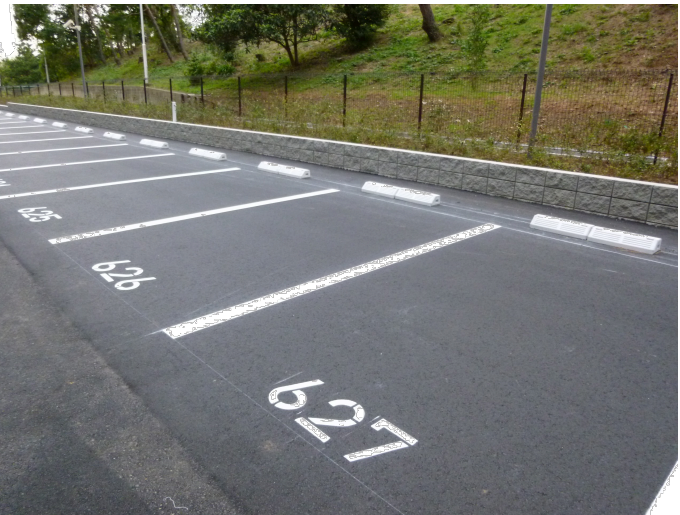
タイヤ止めブロックを2つまとめて設置した事例 ・ブロックがバラバラと配置された印象とならない。 ・車両の停車時に不具合が起こった報告はない。
