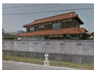
×単調で圧迫感のあるブロック塀
