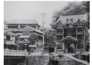
昭和初期の恩湯と枕水の外壁は板張り。軒下は真壁木組み現し
