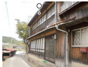
○縦板張り しんかべ と土壁に木組みの外壁
