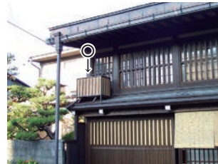
○木柵と簾で室外機を隠す工夫 (高山)
