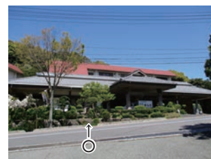
○通り沿いは平屋、奥に高層棟 を建てる配慮
