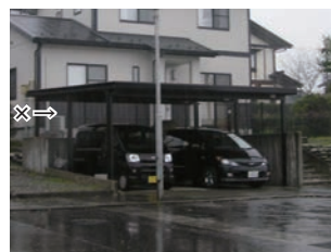
×通りに露出したカーポート
