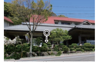
○造園による法面の処理
