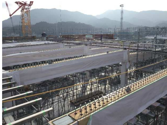
5・R階 木柱・木梁据付完了
