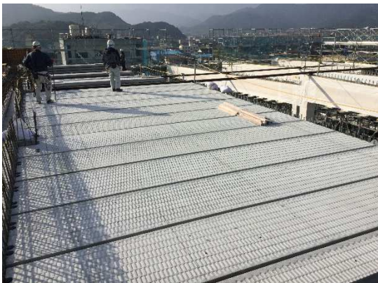
R階 穴あき PC 据付状況
