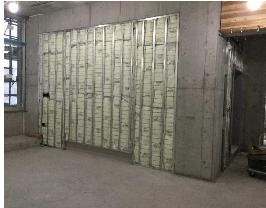
間仕切壁グラスウール貼り状況
