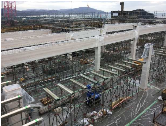
5・R階 木柱・木梁据付状況
