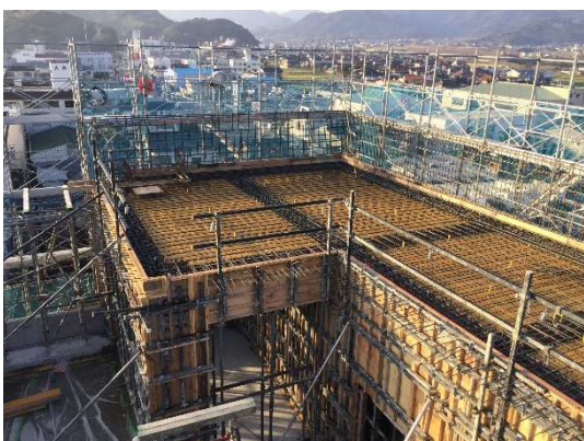
R階 配筋完了(2工区)
