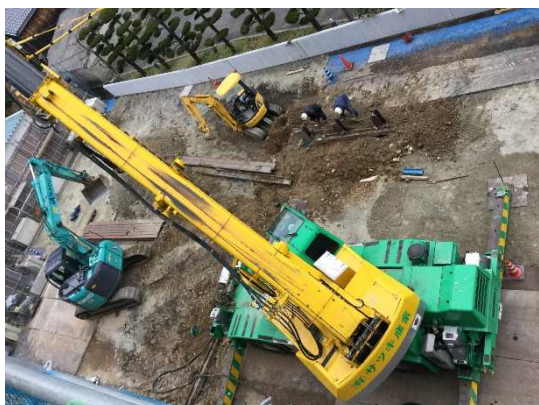
東面 外構工事(熱源装置・オイルタンク)
