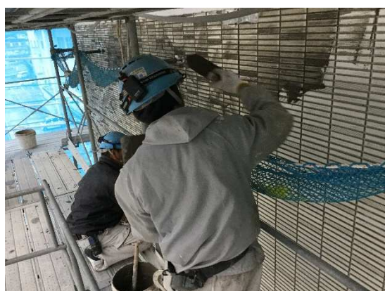
外壁目地入れ状況
