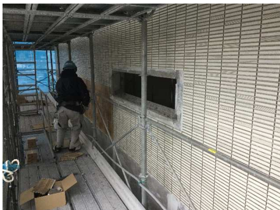
外壁タイル貼り状況
