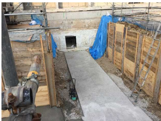
東面 外構工事(ボックスカルバート)
