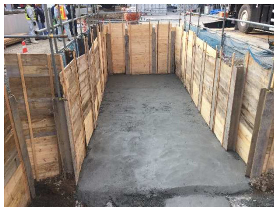
東面 外構工事(オイルタンク)
