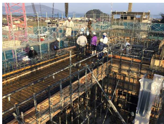
R階 コンクリート打設状況(2工区)
