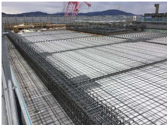
R階 スラブ・逆梁配筋完了
