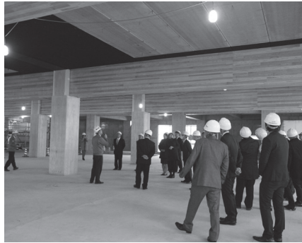
▲現在建設中の長門市役所本庁舎内部
