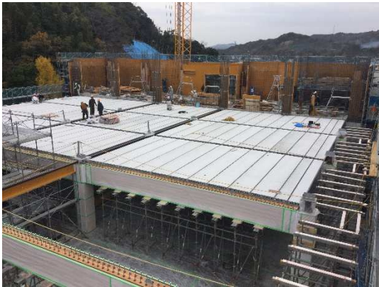
4F 穴あき PC 据付状況
