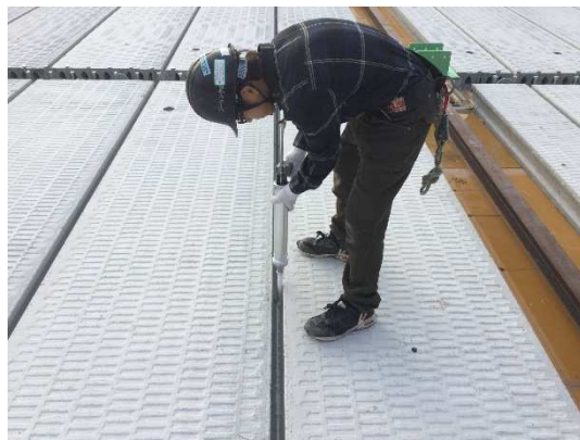
4F 穴あき PC 隙間シール打ち
