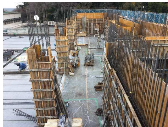
4F 壁型枠建込状況(7-8間)
