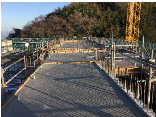
4F 立上り 5F 床コンクリート打設完了(7-8間)
