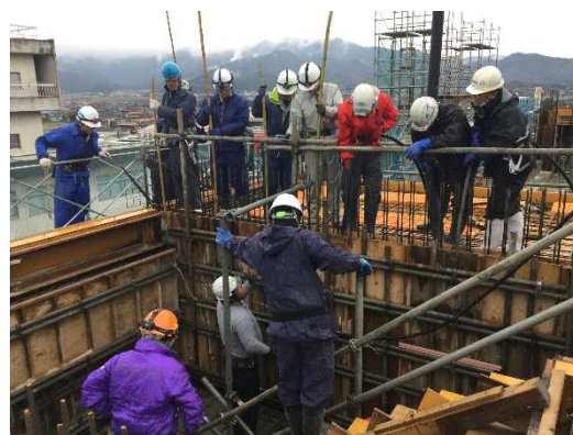
4F 立上り・5F 床コンクリート打設(7-8間)
