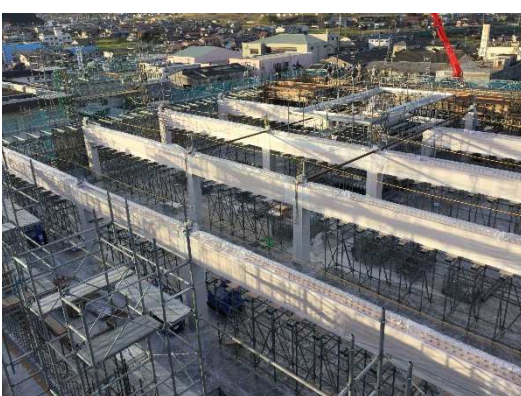
木梁据付状況(2-7間)
