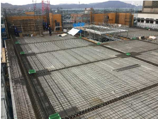
4F 梁・床配筋状況(2-7 間)
