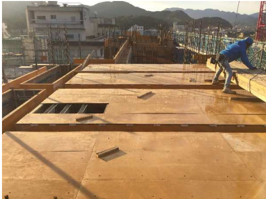
5F 床型枠建込状況(1-2 間)
