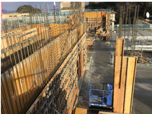
4F 壁型枠建込状況(1-2 間)
