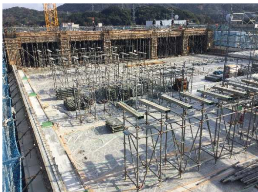
4F 木梁支保工組立状況(2-7間)
