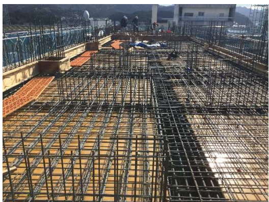
5F スラブ配筋状況(7-8間)
