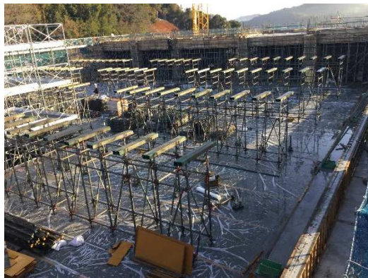
4F 木梁支保工組立状況(2-7間)
