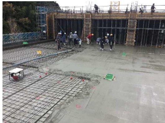
4F 梁・床コンクリート打設状況(2-7 間)
