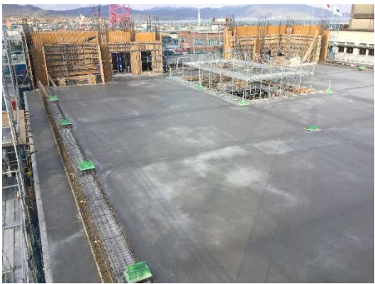
4F 梁・床コンクリート打設完了(7-8 間)
