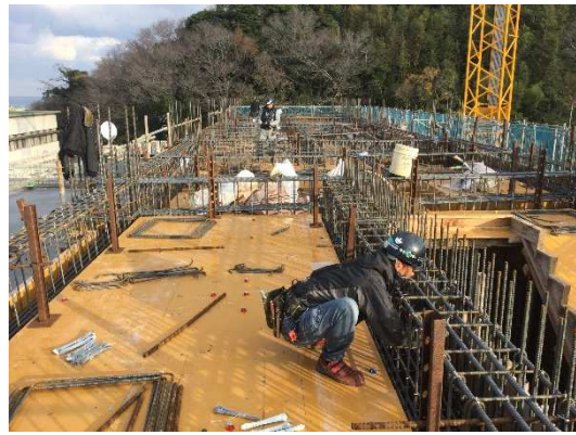
5F 梁配筋状況(7-8 間)
