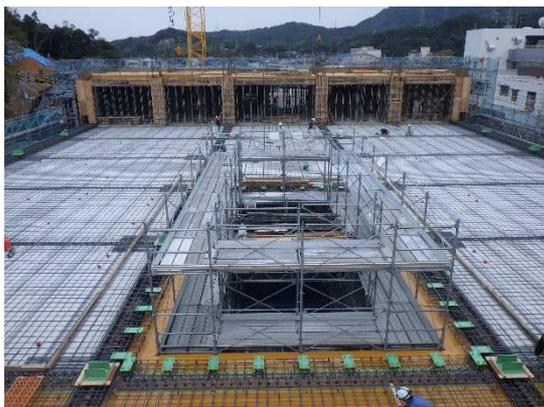
3F(2 工区)打設後の養生状況
