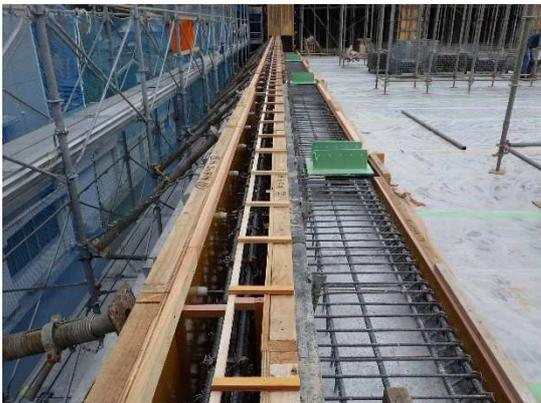
3F(3 工区)腰壁・逆梁コンクリート打設状況
