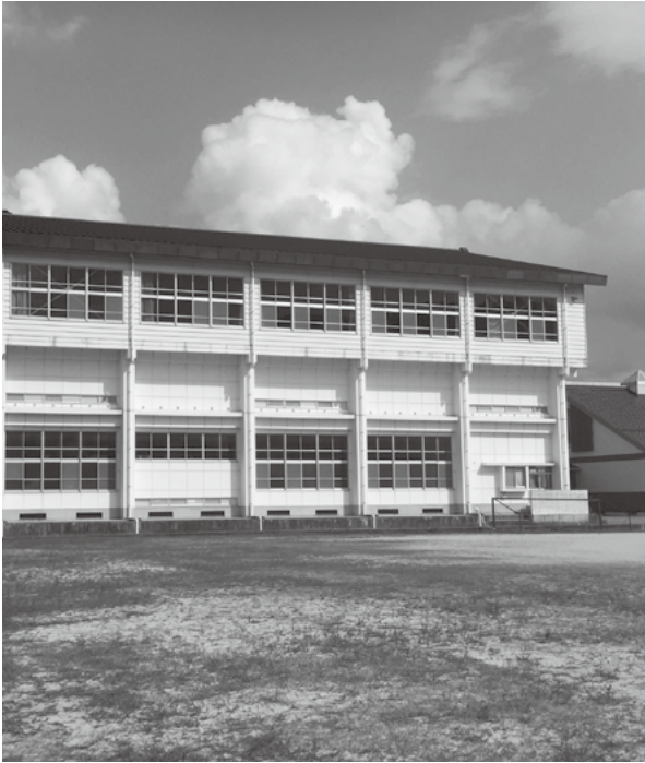
▲改修が行われる三隅中学校の屋内運動場
