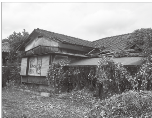
▼老朽化した空き家
