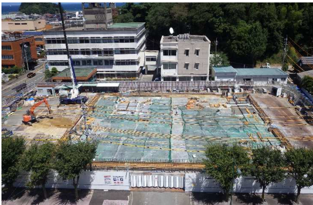
8月17日全景 市庁舎 1F 床コンクリート打設完了
