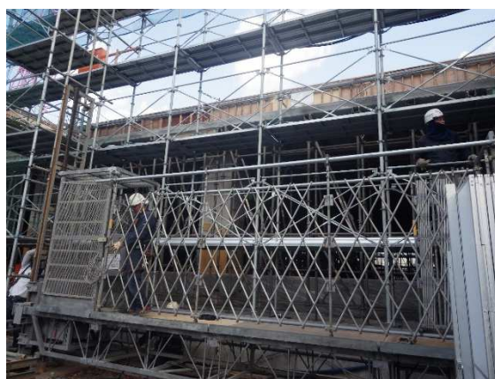
ロングスパンエレベータ設置状況
