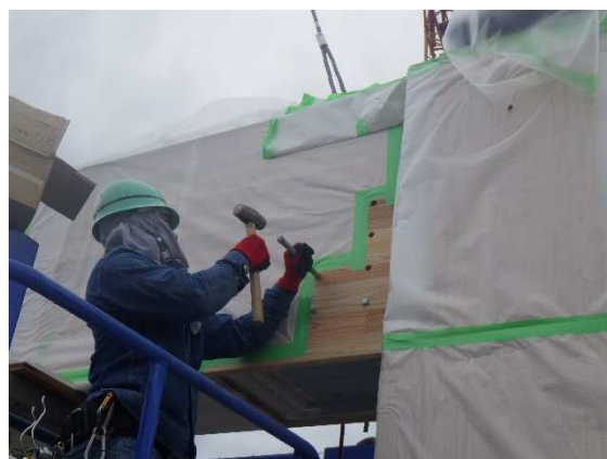
3F 木梁据付状況
