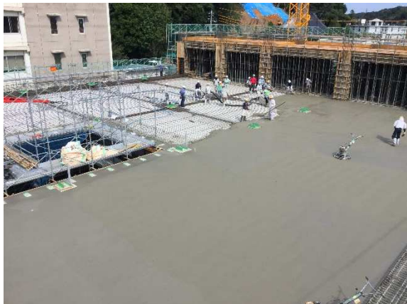
2F(3 工区)梁・床コンクリート打設状況
