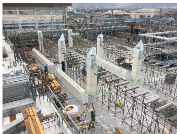
3F 木柱据付状況
