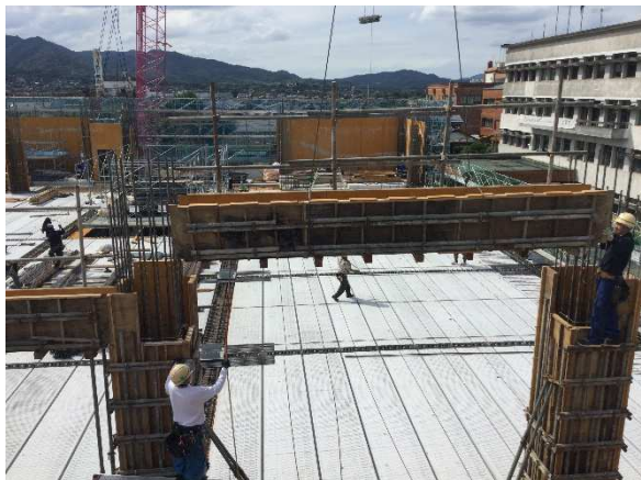
3F 梁掛け状況
