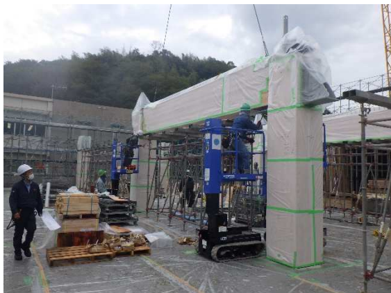
3F 木梁据付状況
