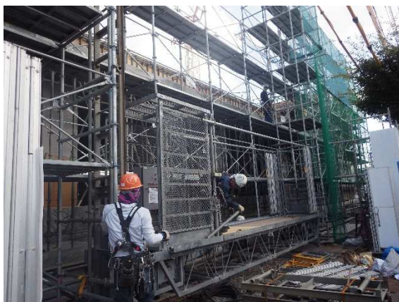
ロングスパンエレベータ設置状況
