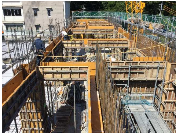
3F 梁掛け状況
