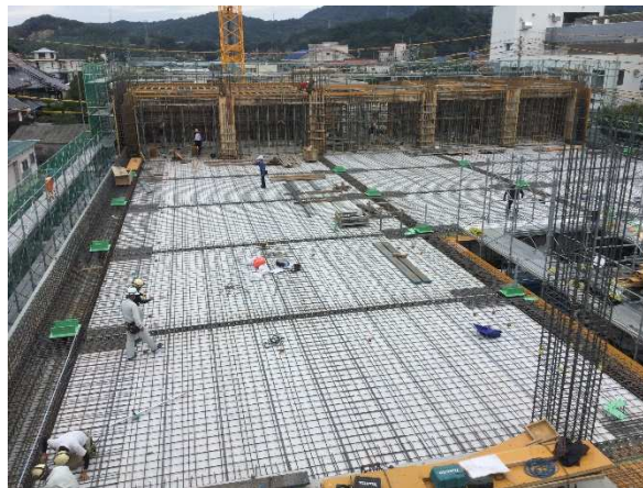
2F(3工区)梁・スラブ配筋
