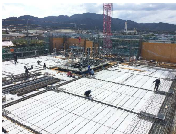
2F(3工区)梁・スラブ配筋状況
