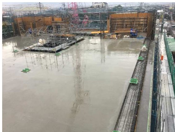
2F(3 工区)梁・床「コンクリート打設完了
