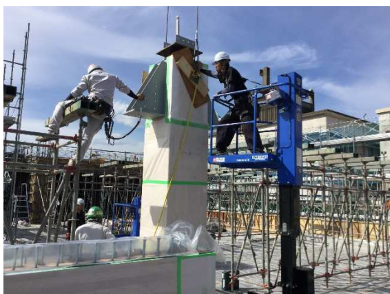
3F 木柱据付状況
