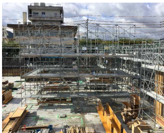
吹抜け足場組立状況
