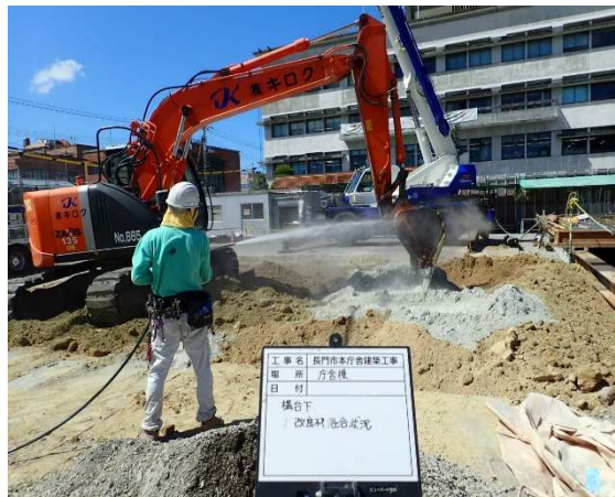
構台スロープ下埋戻し改良材混合状況
