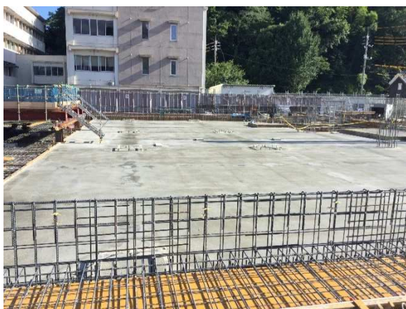
1F床(東側)コンクリート打設完了
