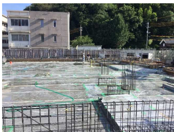
1F床コンクリート湿潤養生のための シート張り
