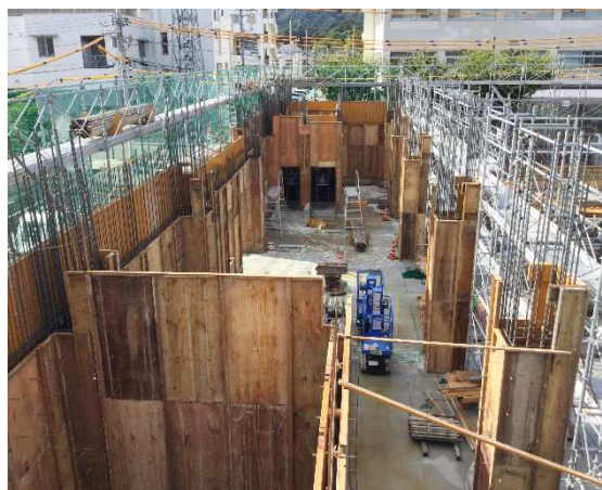
1F 柱・壁型枠組立状況
