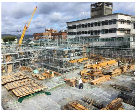
1F 施工状況
