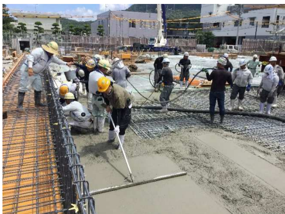
1F床(西側)コンクリート打設状況
