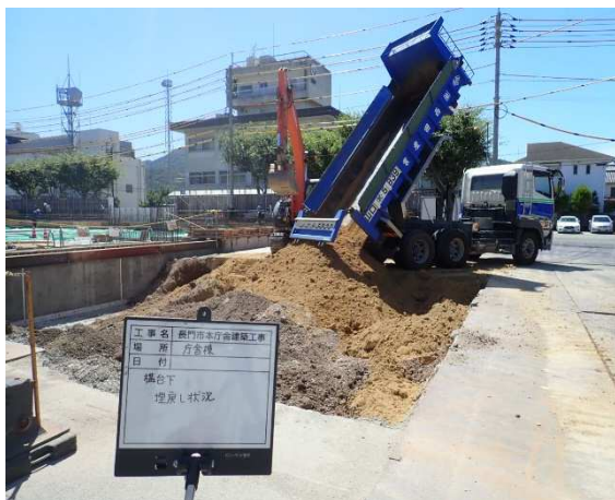
構台スロープ下埋戻し状況
