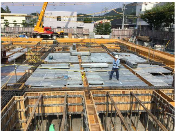
1F床型枠組立
