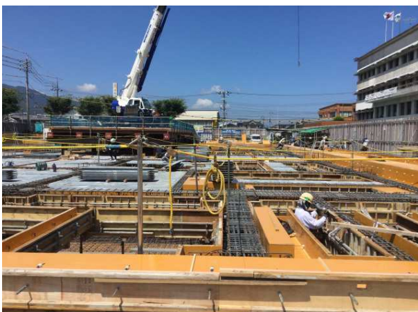
免震上部梁型枠組立状況
