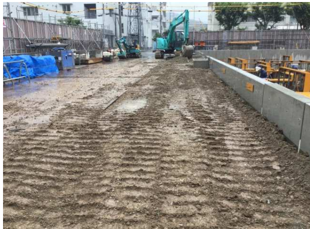
建物周囲の埋め戻し
