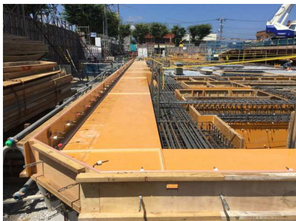
免震犬走り型枠底組立
