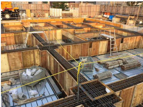
上部基礎梁側型枠組立
