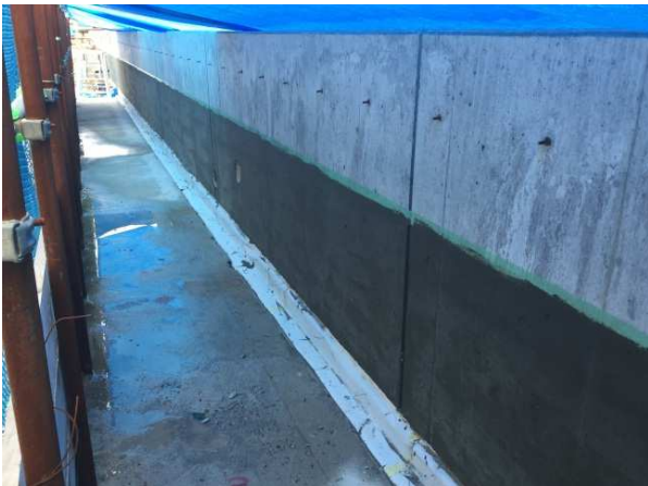
土圧壁の土に接する部分の防水完了
