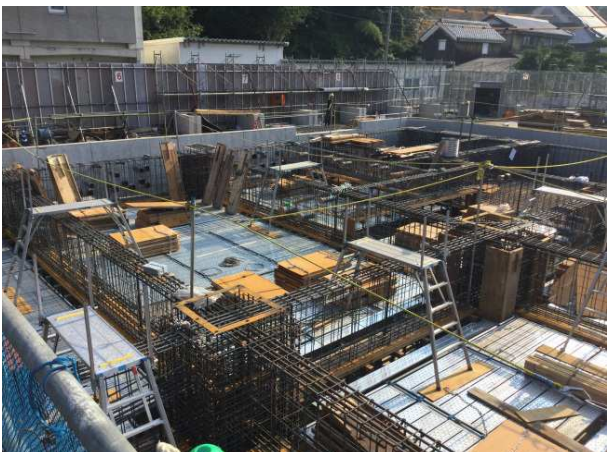
免震上部梁配筋状況
