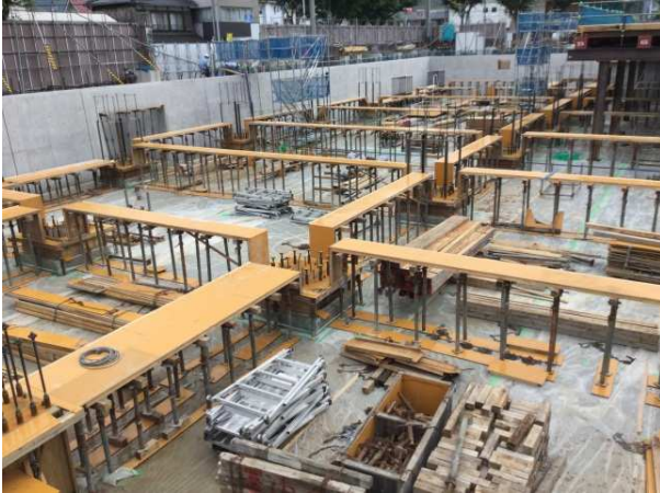
免震階 上部基礎・梁底型枠工事
