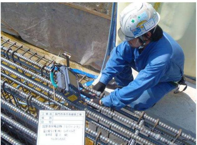
鉄筋の繋ぎ目の超音波探傷検査状況
