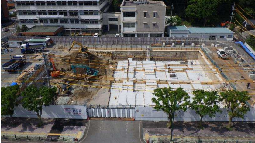
5月1日全景 基礎の位置を決 めるコンクリート打設
