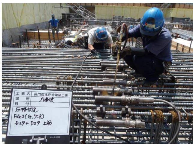
鉄筋をガスで熱して繋ぐ作業
