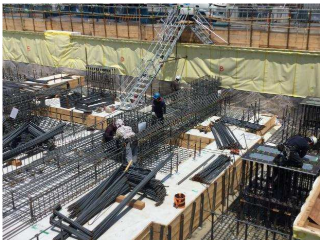
基礎梁組立状況
