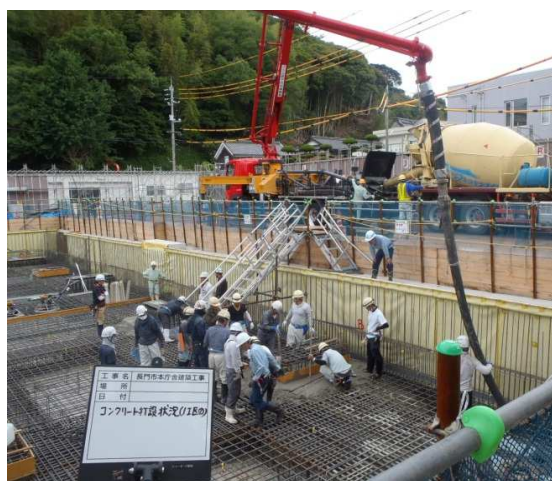
基礎のコンクリートを打設する作業
