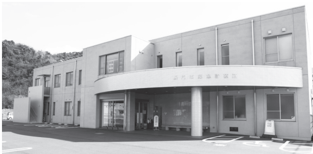
初期救急を担う施設として、県が策定した地域医療再生計画に基づき整備された長門市応急診療所(平成25年10月供用開始)
