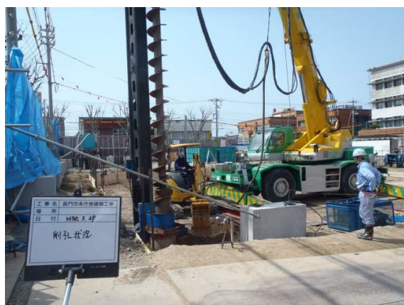
山留めH鋼施工
