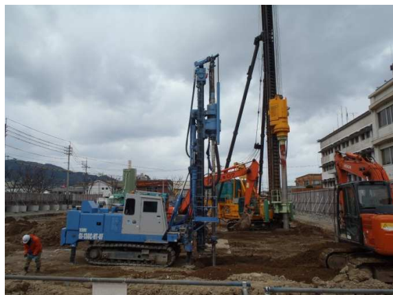
地盤改良杭施工
